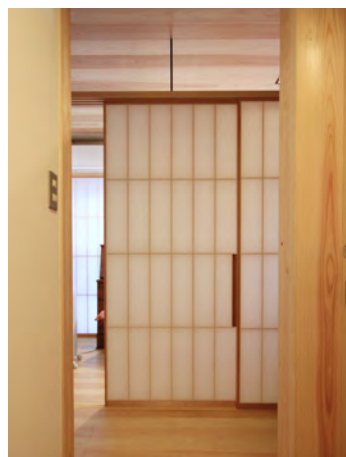
引き戸を開けると、障子がお母さんの部屋の目隠しになっている。欄間はOPENになっており、天井は一体となっている。
