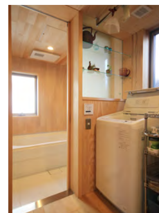
杉板の壁と青森ヒバの床で仕上げた脱衣室。木は調湿作用が高く、水廻りに適している。清潔感もありコロボの定番となっている。
