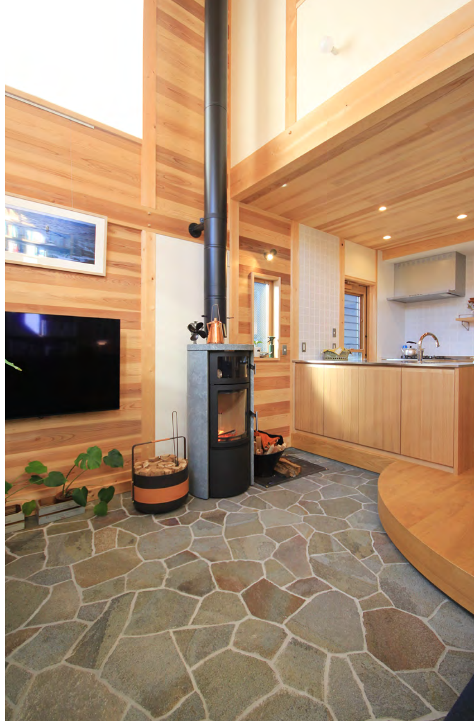
床を諏訪鉄平石の乱張りで仕上げた吹き抜けのある広間。職人が一枚一枚の色や形を合わせながら丁寧に仕上げている。目地の幅を揃えたり、縁起の良い張り方など、職人のこだわりが詰まった床に仕上がった。
