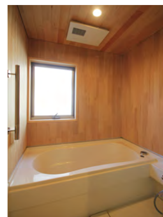
ハーフユニットバスと青森ヒバで仕上げた浴室。天井には浴室換気乾燥暖房機を設置し、暖房や換気、他、浴室の維持にも一役買っている。
