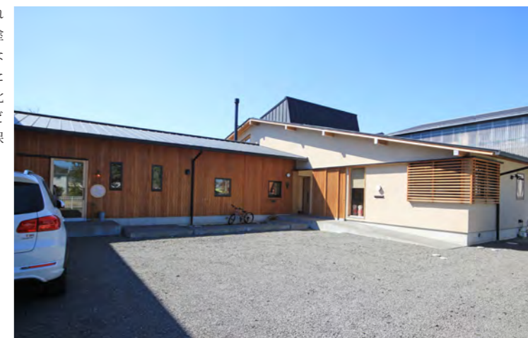
北側外観 T型に配置された『たらの家』。南北棟は塗り壁、東西棟は杉板壁となり、面によって切り替えた外壁仕上げとした。敷地北側は、美容室や事務所などの駐車スペースを広く確保している。
