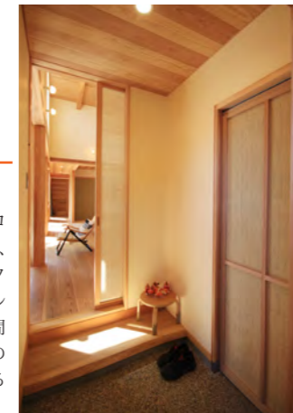
内玄関 住宅の玄関はコンパクトな大きさとし、土間続きでシューズクロークを設けるスタイルとした。洗い出しの土間や葛布のガラス、藤網の建具など、素材感のある玄関となった。
