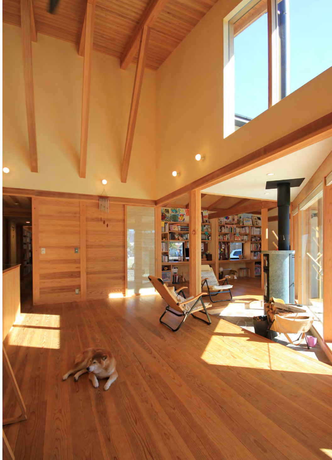
大きな空間を支える方杖構造。構造として必要な方杖ですが、単調になりがちな大きな空間のポイントにもなり、デザイン面からもこの空間を支えている。
