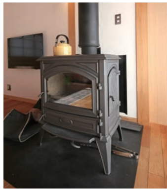
広間の中心に置かれた薪ストーブ。日中は冬でも陽が差し込むととても暖かな室内になるが、夜は薪ストーブを焚いて木の家を暖めている。薪ストーブはダブル社の640CB。正面に加えてサイドに扉があり、薪の投入も便利と好評。
