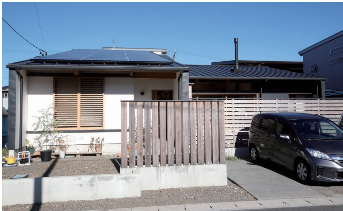
上) 南側からの外観。室内のダイナミックな空間とは対照的に、高さを抑えた落ち着いた佇まいになった。中庭を囲う板塀と玄関の目隠しとして建てた列柱でプライバシーを確保し、外部からの視線を遮っている。和室の窓には開閉出来る格子窓を取付け、日射の調整や通風などの目的と合わせてこの家のアクセントとなっている。
