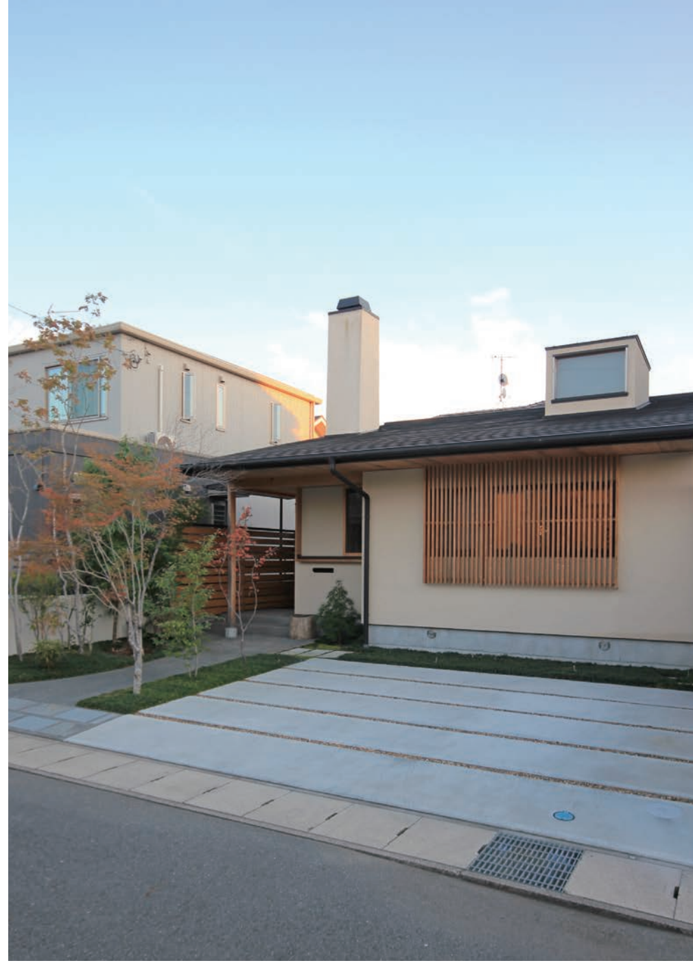
北道路からの外観。窓の縦格子と、屋根に突き出した煙突と塔屋がアクセントになった。煙突は通常の断熱煙突を壁で囲み、オリジナルで製作した角トップを設置した。シンプルだが個性的な外観となり、機能とデザインが重なったファサードとなった。
