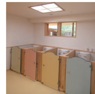
カラフルな扉が可愛いトイレ。間仕切り壁にJパネルを採用。木の温かみの感じられるトイレとなった。
