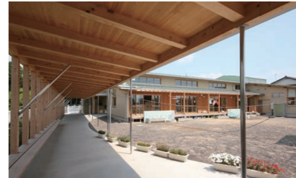
アプローチ屋根。今回の大きな特徴となっているアプローチ屋根は、雨天時の助けになればと思い設けた。また、園庭での行事の際の観客席としてベンチも備えている。
