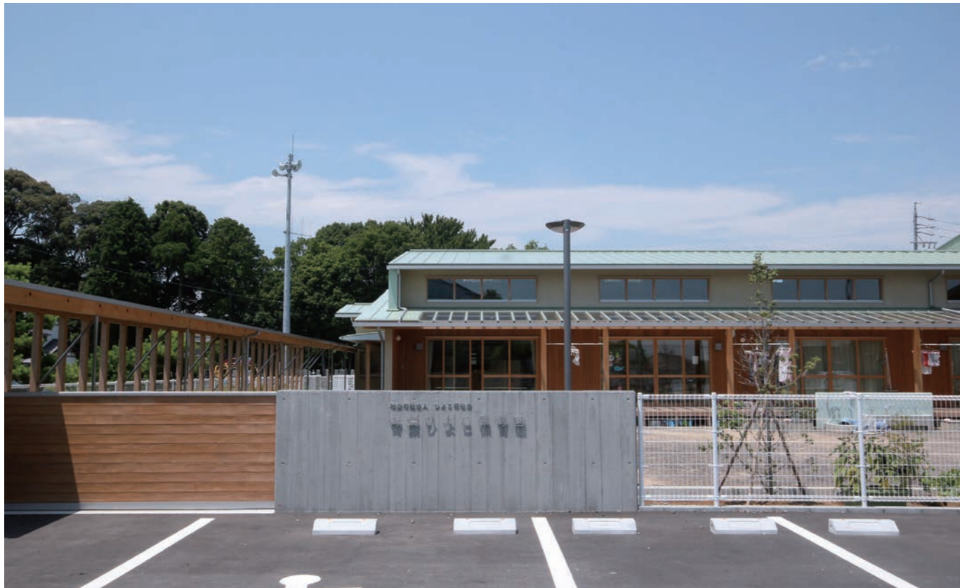
送迎用駐車場から建物外観を見る。周辺の木々や広がる青空に合わせ、アースカラーを基本に落ち着いた色合いの外観となった。門扉やアプローチ屋根などもひとつひとつ職人の手仕事で製作した。
