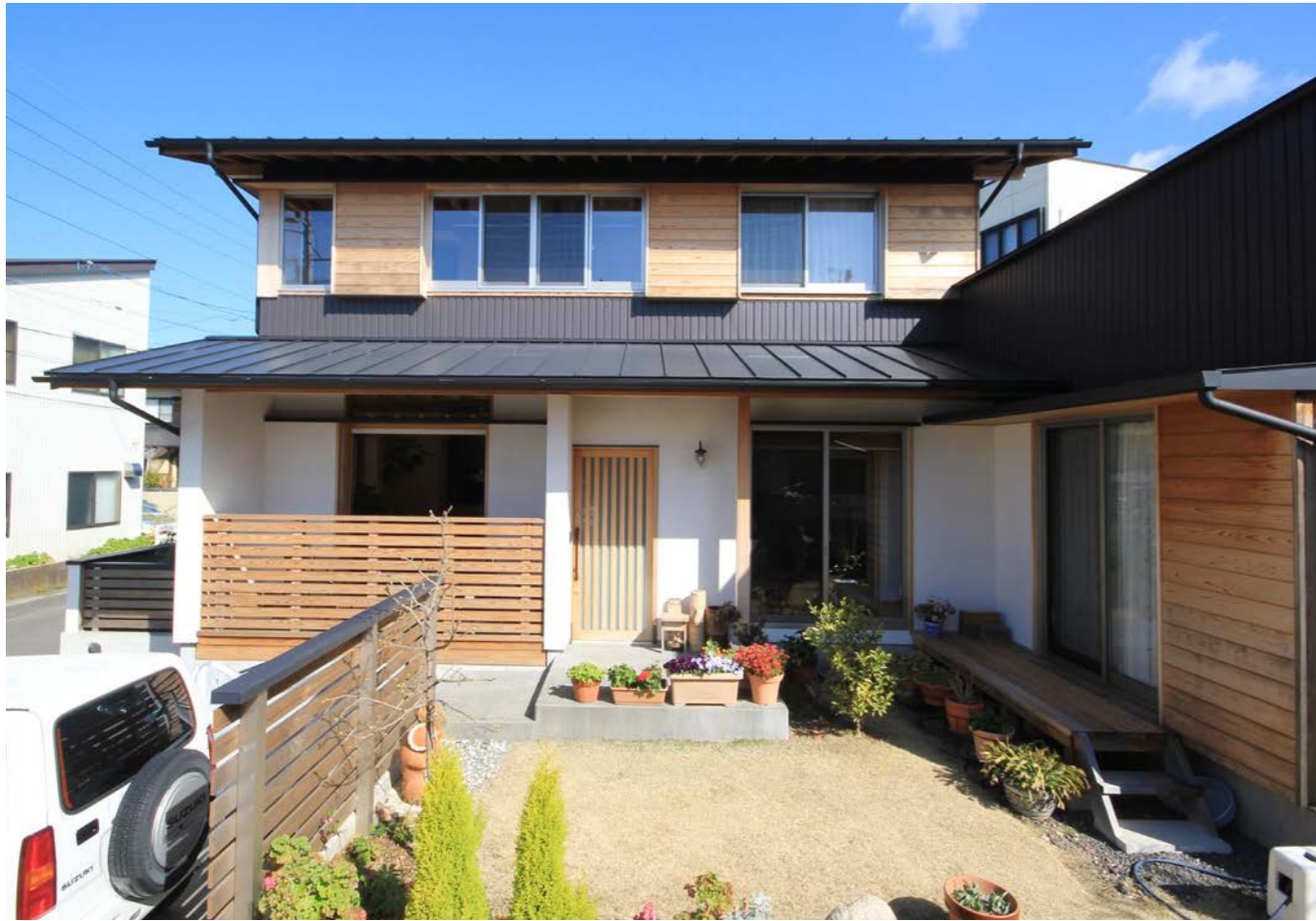
外観を南から見る。左官で仕上げた壁と戸袋板をアクセントにした外観。建物はL型配置とし、中庭を囲んで子世帯と親世帯が分かれている。
