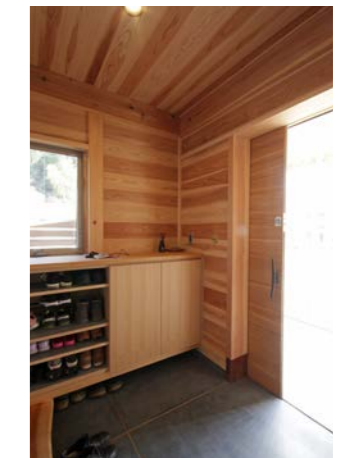
玄関： 墨モルタルで土間を仕上げた玄関。板倉の木の壁と合わせて、コンパクトでシンプルな玄関とした。
