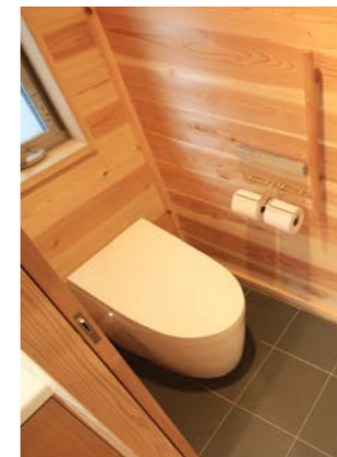
杉板の壁とサーモタイルの床、シンブルなトイレの内装だが、どちらも綺麗に長持ちする安心の素材。
