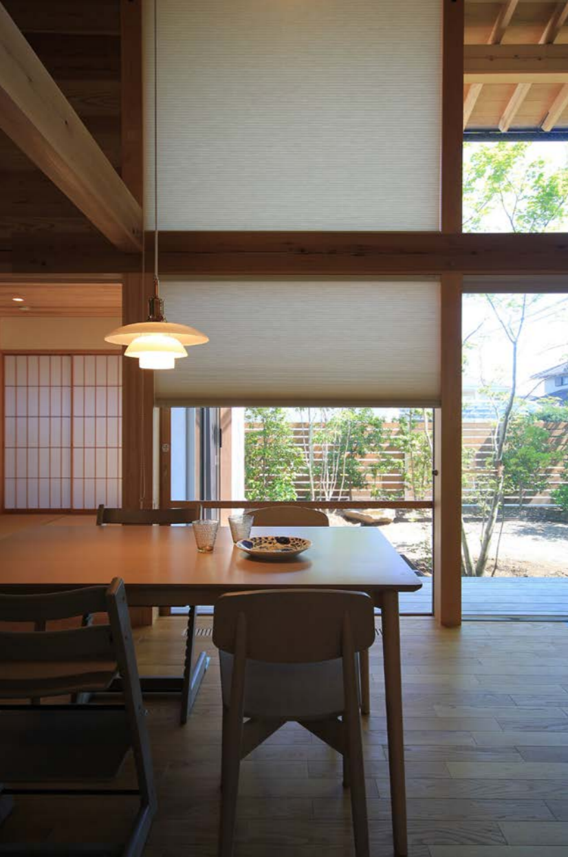
ダイニングの大きな窓に設置したハニカムサーモスクリーン。ハニカム形状を利用した断熱性能の高いスクリーンとなっている。また、障子の様な透け感があり、日射を遮りつつも柔らかな明かりを室内に届けてくれる。
