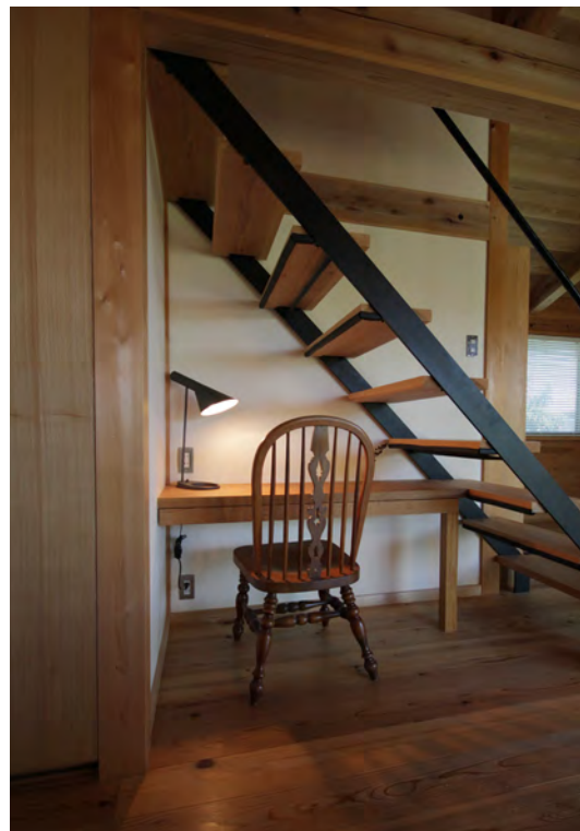
階段下のスペースに設けたカウンターコーナー。アンティークのウイングチェアが個性的な雰囲気を出している。階段のササラと手摺はアイアンで製作、木でつくると重たい印象になる階段も、アイアンでつくると軽やかにつくることができる。
