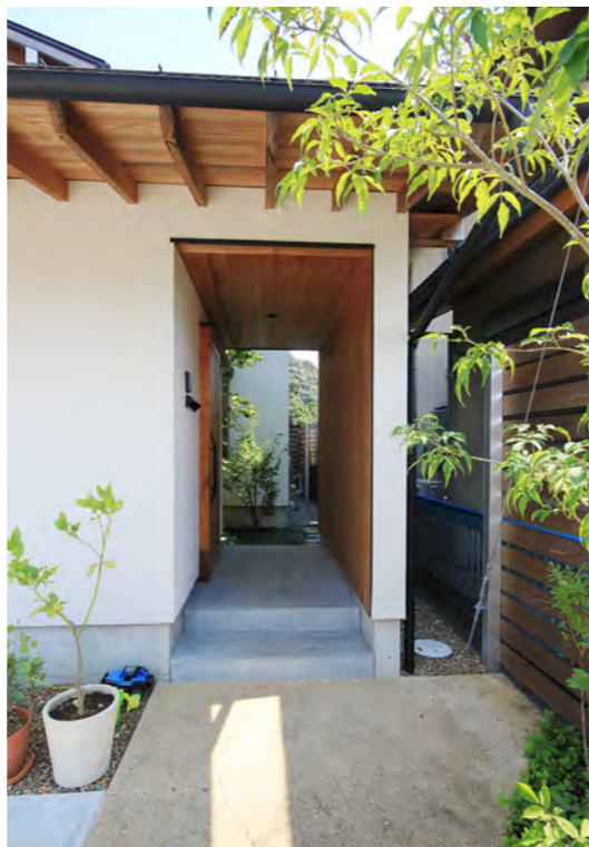
玄関を少し下げて大きな屋根で囲う事で、道路からの視線を避け、雨や風の影響を受けない玄関ポーチになった。さらにHさんのお宅は坪庭まで通り抜けられるようにした事で風や視線が抜け、緑の見える心地よい玄関ポーチが出来た。
