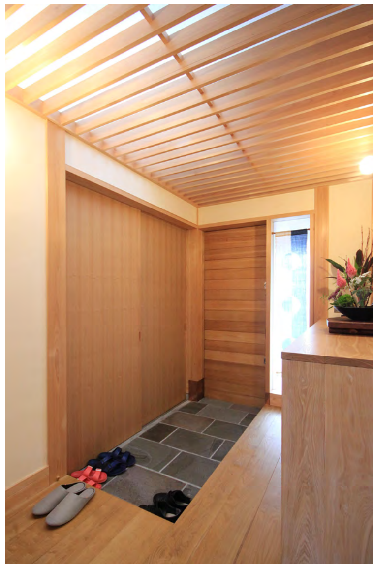
玄関内部。天窓に格子障子をはめた光天井。玄関全体が柔らかな光に包まれ、一日を通して明るい玄関になっている。
