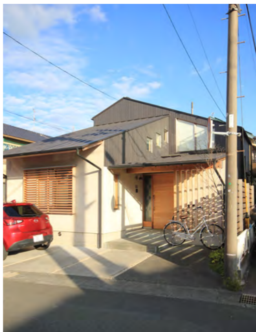
西から望む外観。玄関周辺に自転車置き場と駐車スペースを設け、毎日の暮らしに合わせた動線計画とした。
