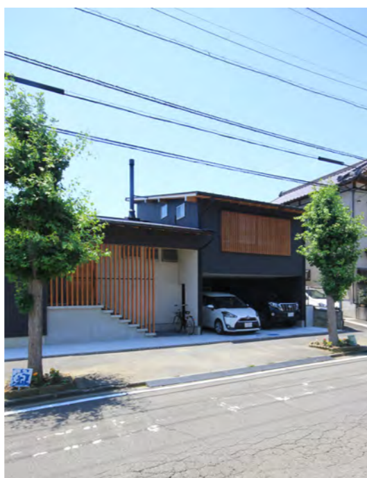
北側道路からの外観。2台分の車庫を建物内に取り込み、高低差を利用してスキップフロアーのプランをつくった。玄関アプローチの縦格子もアクセントになっている。
