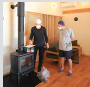
集めたススの状態を見ながら焚き方診断。ススの状態と、1シーズンに使った薪の量とススの量を比較している。
