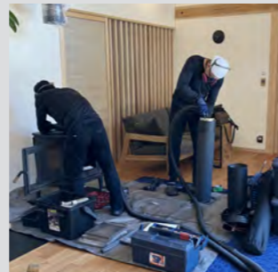
本体と煙突を外し、それぞれの内部を掃除機とブラシで綺麗に掃除。
