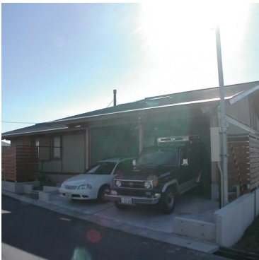
新築時の外観。門塀や板戸が無くオープンな車庫でした。出入は楽ですが、何処と無く落ち着かない感じがしていました。
