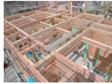
『木箱の家』の建前の様子。6尺「一間」ずつ、上下に梁が掛かり、見た目にも安心感を与えてくれる。
