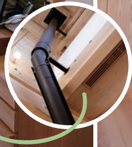
カウンターには吹出口あります。薪ストーブの暖気で足元を暖めようという試みです。
