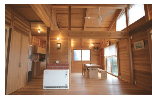
蓄熱暖房機をリビング・ダイニングのほぼ中央部に設置し、上部にはサイクルファンを取り付けました。サイクルファンは、冬場には、暖房で暖められ上に溜まった空気を下に下げる事を想定しています。
