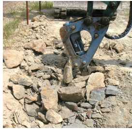
この泥岩の岩盤には、最後まで職人さん達が掘るのに苦労したツワモノです。削岩機を取り付けた重機を使った作業は、迫力がありました。
