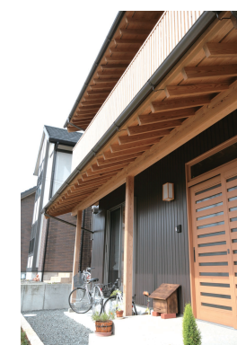
庭側の軒を深くし、夏場の日差しを遮るだけでなく、軒下の利用もできる。垂木の間隔を尺(303mm)と細かくしました。
