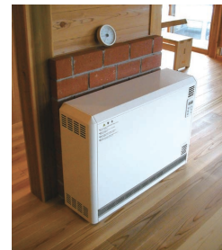
深夜電力を使った電気蓄熱暖房機。中に入ったレンガが蓄熱材料となっており、蓄熱が完了してからジワジワと放熱していきます。
