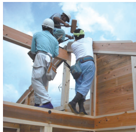
大工さん達がカケヤを使い、約一ヶ月ほどかけて刻んだ柱や梁を納めていきます。組立順序や柱の傾きなど必要所で、棟梁のチェックが入ります。
