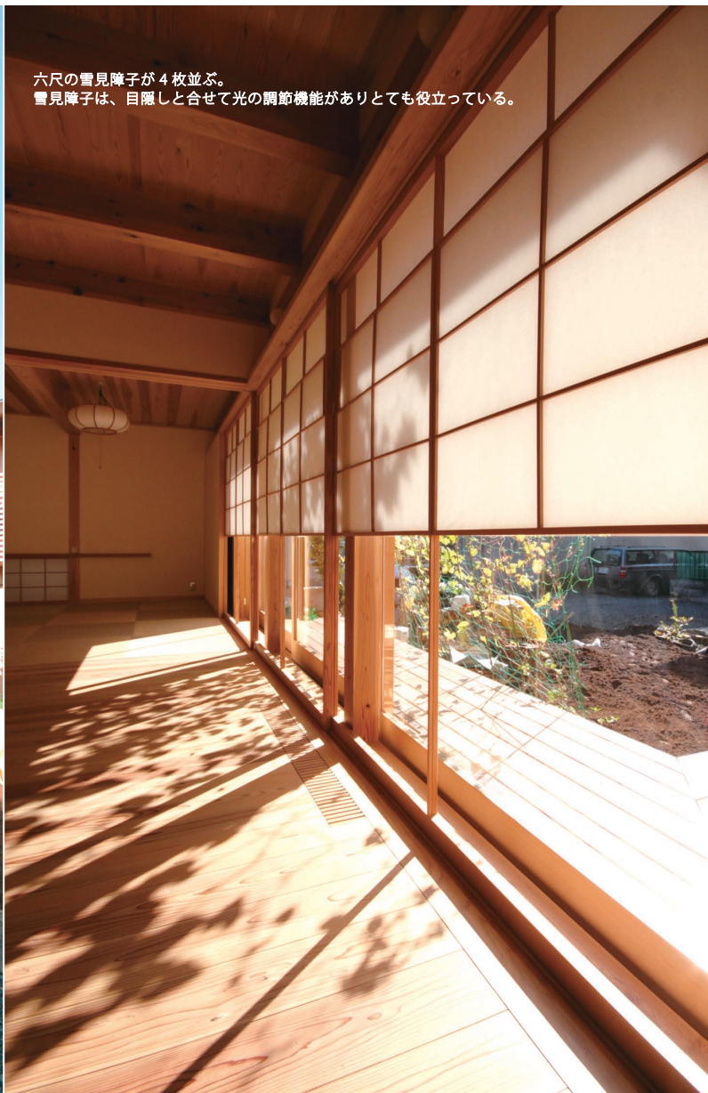
親世帯の広間 2階床の梁組みをそのまま現した天井と、六尺の大きな建具が特徴的な広間。 お施主さんがあつらえた墨久杉の座卓の存在感が、この部屋の雰囲気を作っている。
