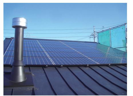
SO-RAの家のタイトルに相応しく、大きく葺き下ろした屋根には、太陽光発電パネルが設置されています。発電量は、少し大きめの5キロワットです！
