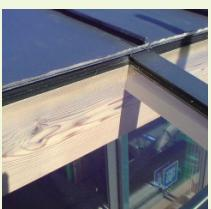
板金屋さんのお手伝いをして、ガラスを下から差し込みます。ガラスと板金の間に隙間が生じないように、パッキン材やコーキング材を用いて、雨仕舞をしていきます。屋根面なので、強化ガラスや合わせガラスを用いていくのは当然ですが、室内に設置する時は、上記に加えて複層ガラスとします。
