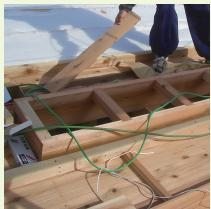
屋根面を開口し、天窓の下地を組んでいます。屋根工事と平行して進むので、手早く製作することができます。そしてこの時、板金屋さんの仕事を考慮して、下地材の高さや勾配を確保していくことが重要です。
