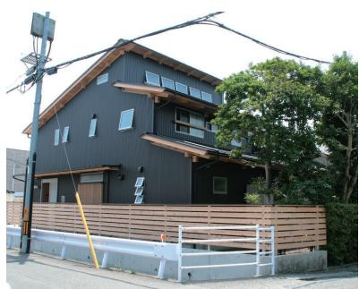
北側からの外観。ロフトに設けた排気用の連続窓。屋根形状を利用して、風の通り道を確保している。
