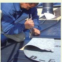
大工の作った下地に合せて、ガラスの差込み部分を造っていきます。ガラスは下から差込むので、3方にコの字型の板金を取り付けます。板金の折りひつで、雨仕舞が左右されるので、とても重要な役割です。
