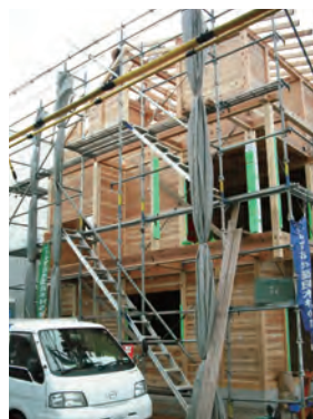
Jパネルを落とし込んだ建前の様子。初めての試みだったが、手際よく進み無事上棟できた。
