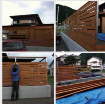
中庭や玄関先など、プライバシーの確保のために板塀を設けています。業者にアルミ柱を建ててもらい、塗装した杉の赤身板をビス止めして製作します。横貼、縦貼、板の隙間の大きさなどでも表情が変わり、外観にボリュームを与えてくれます。
