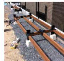
**4** 東石を据え、金物で接合した土台部分を設置します。東石の高さや位置も正確に見ておく事が重要です。
