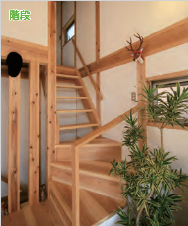
階段 広間に設けたロフトへの階段。回り階段とスキップ階段のコンビネーション。広間のアクセントにもなり、楽しげな雰囲気をつくっている。
