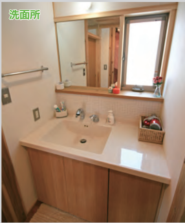
洗面所 人工大理石の天板のみ購入し、扉やガラス、棚板を合わせて作るオリジナル洗面化粧台。ローコストでシンプルな造りだが、綺麗にまとまり違和感を感じさせない。
