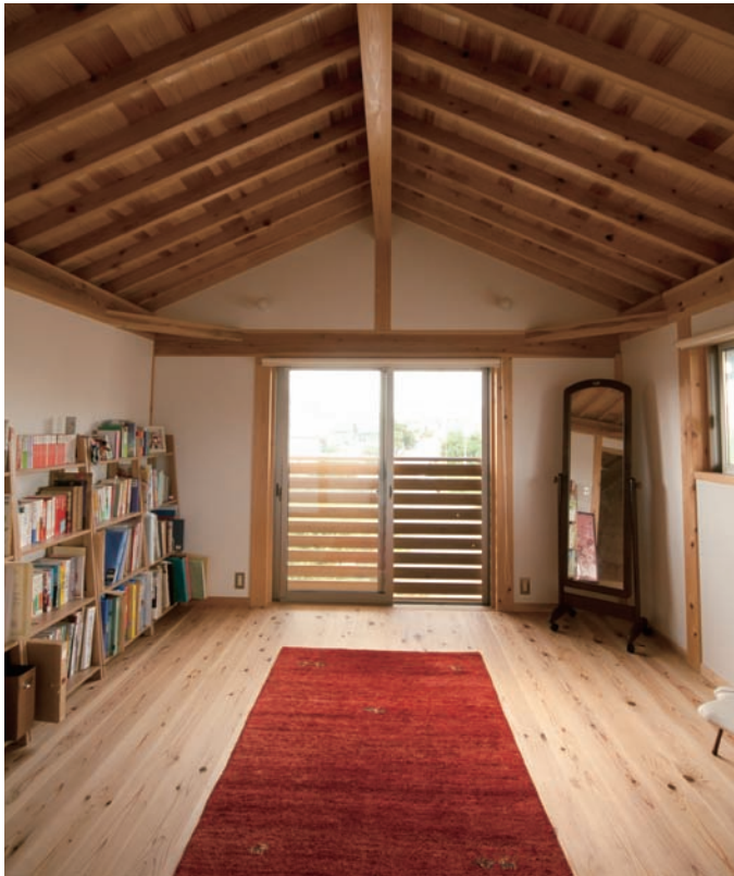
将来は子供室として使う予定の2階の板の間。広く使うためために屋根形状をそのまま現した天井が特徴的。リズムカルな垂木の配置がとても綺麗。
