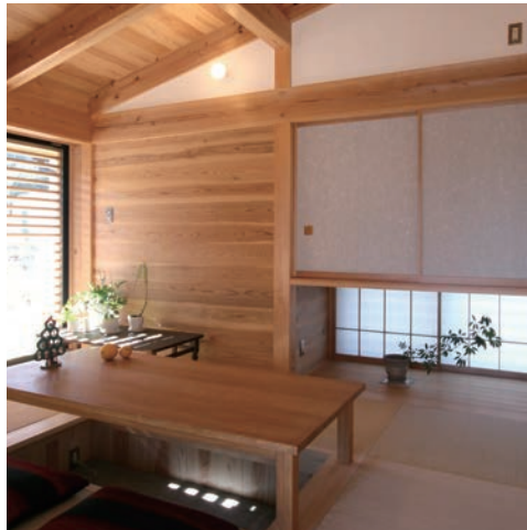
和室には奥さん希望の堀座卓を製作し、コタツとしても利用できるように工夫した。テーブルは床下に収納することが出来るため、夏場などにはフラットの和室として客間などにも利用できる。窓際にはいつも植物が飾られ、来客を楽しませてくれている。
