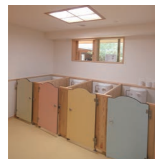
カラフルな扉が可愛いトイレ。間仕切り壁にJパネルを採用。木の温かみの感じられるトイレとなった。
