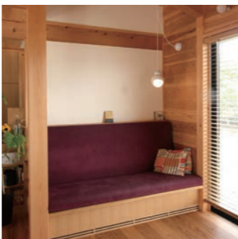
広間の一角に設けた造り付けのソファコーナー。大工が下地をつくり、クッションをマジックテープで止めた簡単な仕組み。子供たちのお気に入りの場所にもなっている。
