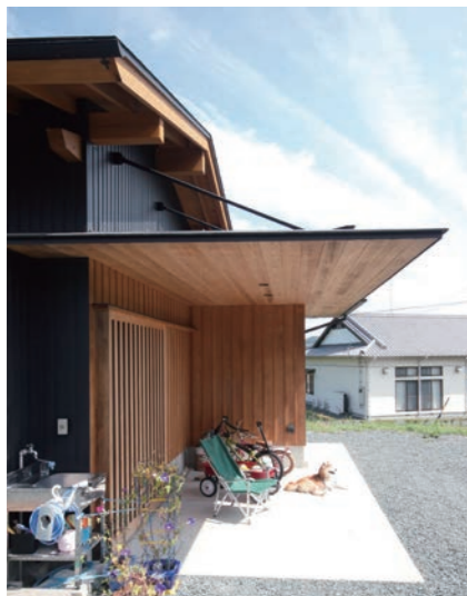
愛車の手入れもこの場所で行いたいという事で無柱の大庇を製作。特注のステンレス金物を製作し、大きな庇を上から吊る構造を考えた。
