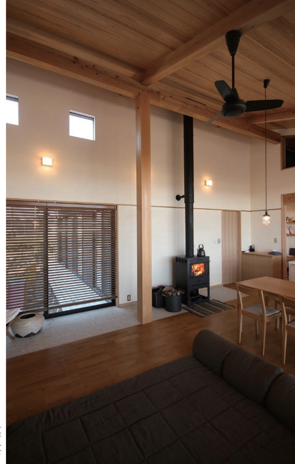
広間の中心に設けた薪ストーブ。露台に大谷石を敷き詰め、そのまま窓際まで伸ばした仕上げとし、ダイレクトゲインの蓄熱体としても利用している。
