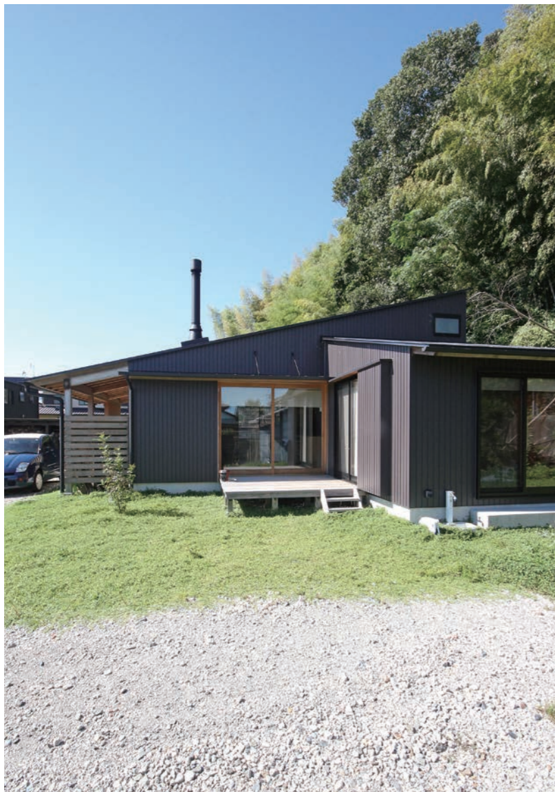
こげ茶色のガルバリウム鋼板の外壁に、広間の大きな木製窓がポイントになっている。庇や戸袋なども製作し、シンプルな形状の中に機能を併せ持つ外観となった。
