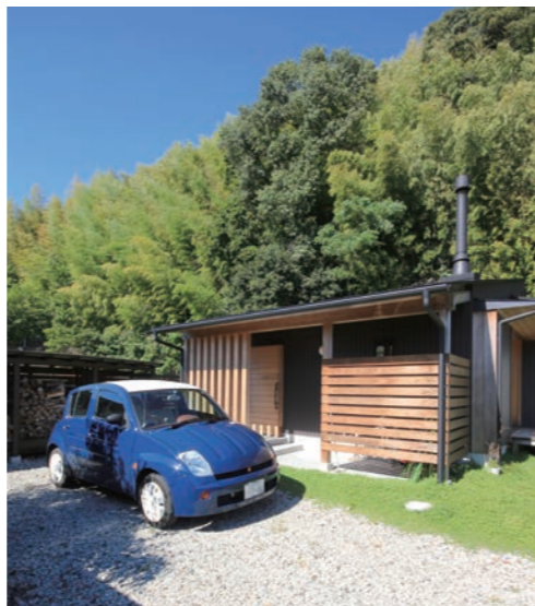
2P) 板倉構法(JPウォール構法)でつくる木に包まれた空間。柱、梁、落とし込み板壁、化粧野地板、全てが構造材であり、仕上げ材となるのが大きな特徴。通常は漆喰壁を併用して仕上げる事が多いが、Oさんのお宅は機能美を生かした“すっぴんの木の家”を目指した。
