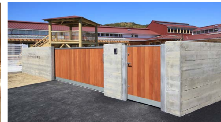
杉型枠でつくられた扉と杉板でつくられた門扉。大きな扉は園庭から出入りできる車両用出入口。
