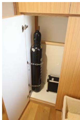
分娩室から使える酸素ボンベは反対側の脱衣室の収納の中に。いざというときに必要だが、見えていると不安を与えるので隠した。
