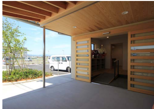
玄関ポーチと玄関建具。利用者だけでなく、地域の方や他の団体の方も交流できる施設とするため、玄関スペースを広めに確保した。玄関建具は桧で制作した自動引戸になっている。
