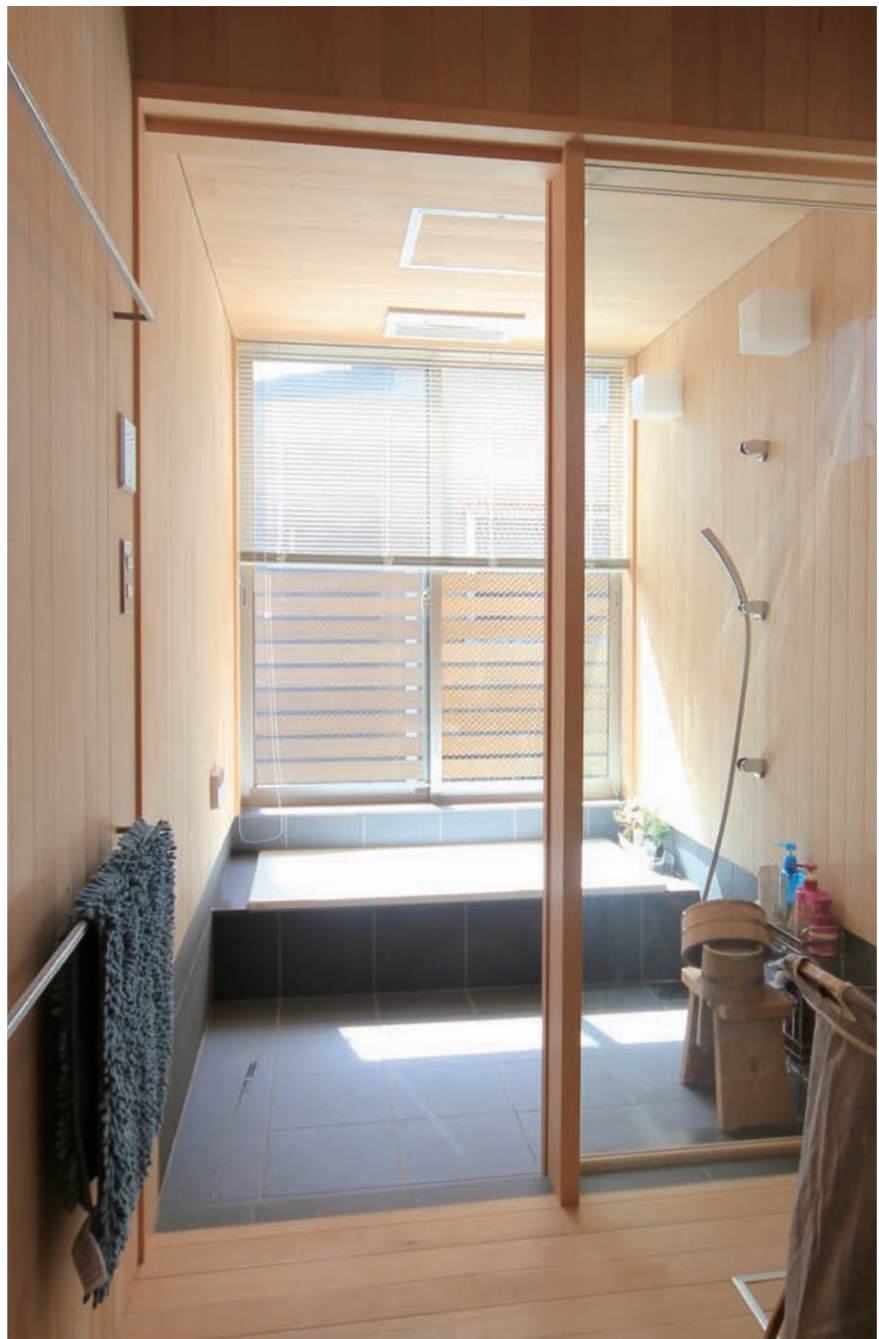
2P) 大きなコーナー窓が特徴の『ひとつの家』の浴室。窓の配置や浴槽の設置方法を工夫することで、同じ大きさの浴室でも開放感のある雰囲気をつくる事が出来る。腰壁と床には諏訪鉄平石を使用。自然味のある素材感を味わえる浴室に仕上がっている。
