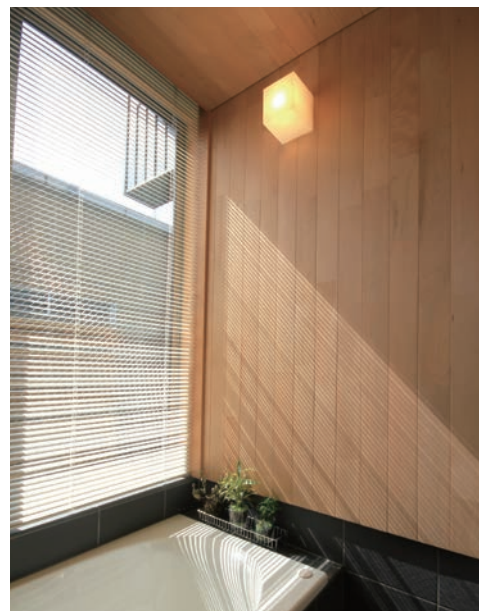
3P下) 浴室を南側に配置する事で十分な採光を得る事ができる。明るい浴室はカビの発生を抑え、木のお風呂にとって良い環境になる。
