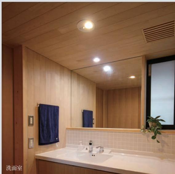
トイレや洗面化粧室などに設置することの多い人感センサータイプのダウンライト。人が近づくと点灯し一定時間後消灯する。消し忘れがなく経済的な利点の他、二方向から出入りする部屋や、スイッチがつけにくい場所にも重宝する。
