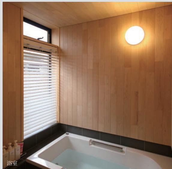
浴室に取り付ける照明器具は、屋外でも設置出来る防雨、防湿型の器具を選択する。ガラスや樹脂のカバーで電球が保護され、水や湿気が内部に入ら無い構造となっている。ブラケットやシーリングの他、ダウンライトタイプも選択出来る。
