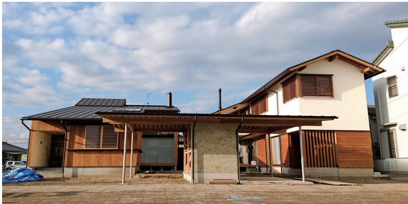
『ツナガリの家(右)』と『ここらぼの家(左)』。家の形やボリュームは違うが素材や色合いを統一し、全体として一体感を出している。共有の車庫兼薪棚は中庭の目隠しの役割を兼ねている。今はまだ建物だけだが、夏に向けて庭づくりをする予定。
