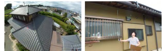
撮影用の棒を使って屋根瓦を確認。屋根に上らなくても見ることが出来、瓦の割れやズレなどをチェックする。外部にもチェック項目は多い。既存の図面が無い時は、後の改修設計のために高さや大きさを測るのも調査の仕事。
