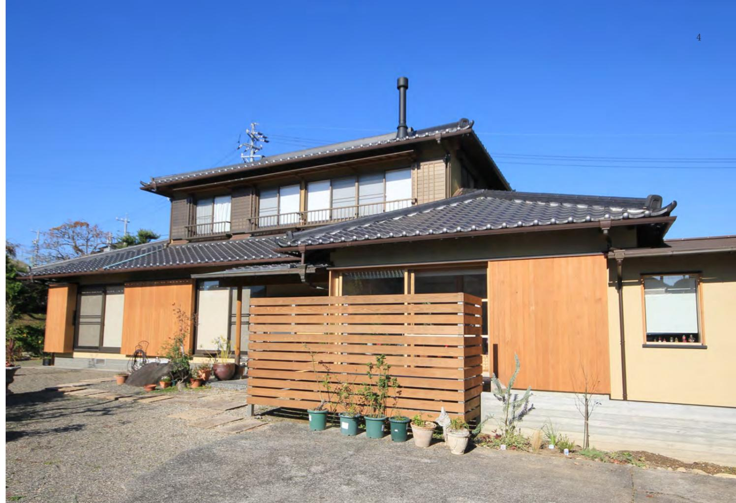
**After** 改修後の外観。全体としては大きな変化は無いが、南面の大きな窓を耐力壁にし、その部分を戸袋として外観を整えた。柿渋色の色合いが明るい雰囲気をつくっている。
