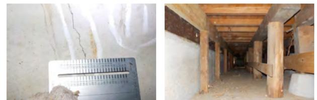
基礎のひび割れをチェック。大きなひび割れは水が浸入して基礎の中の鉄筋を錆びさせる事があるので注意が必要。築30年以上経過する建物は、床に断熱材が入っていないことが多い。家が寒い、底冷えする等の問題はここにある。
