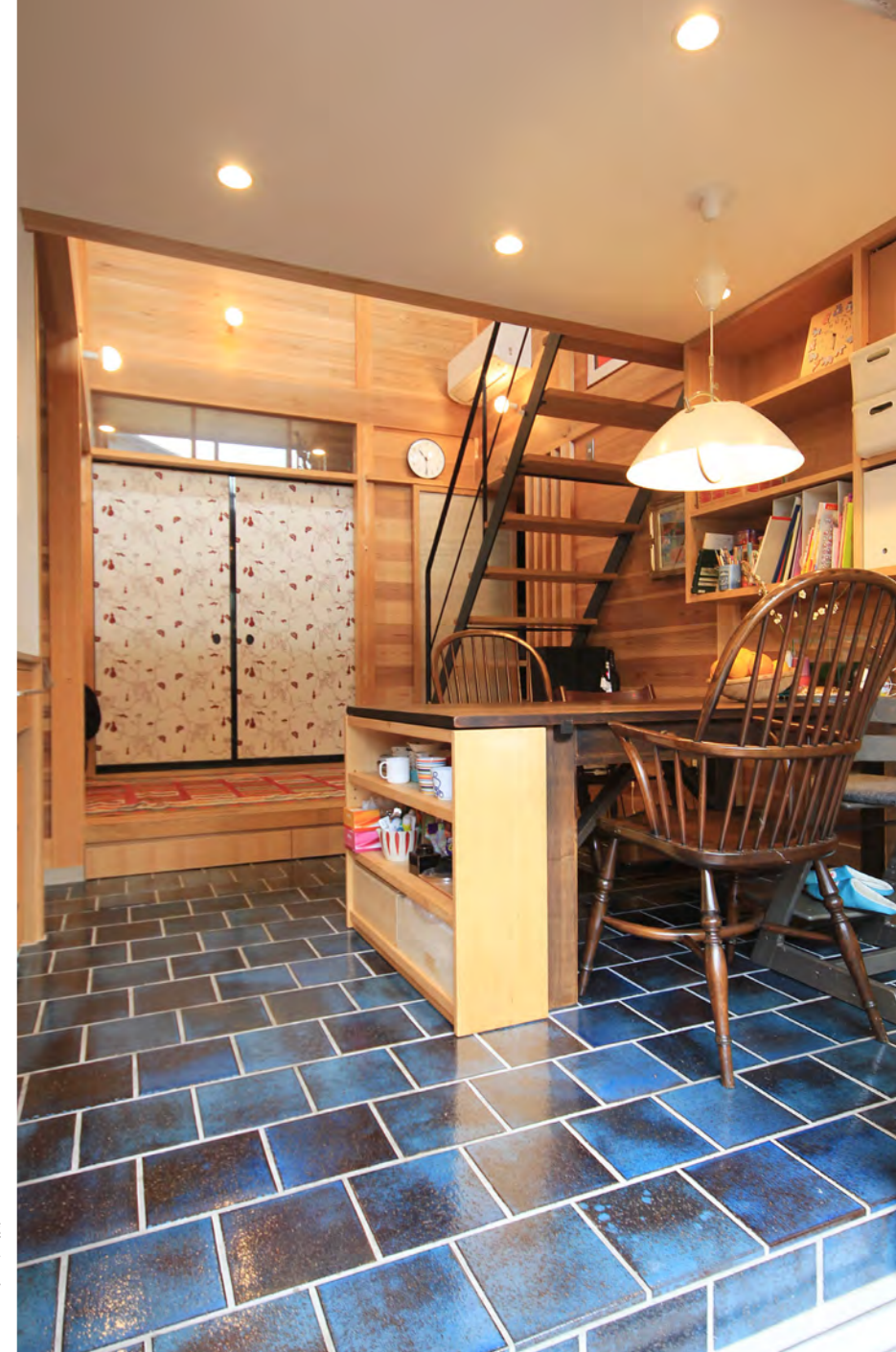
ダイニングの床に張った青い釉薬のタイル。色斑があり、見る角度で違った表情を見せてくれる。タイルは思ったより冷たくなく、足触りも心地いい。
