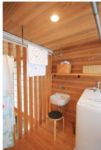
サンルーム……2階の一角にバルコとサンルームを設けた。サンルームには洗濯機と洗濯流しを配置し、機能的なスペースとした。吹き抜けとの境に縦格子を設け、風を通しながら目隠し機能もある壁とした。
