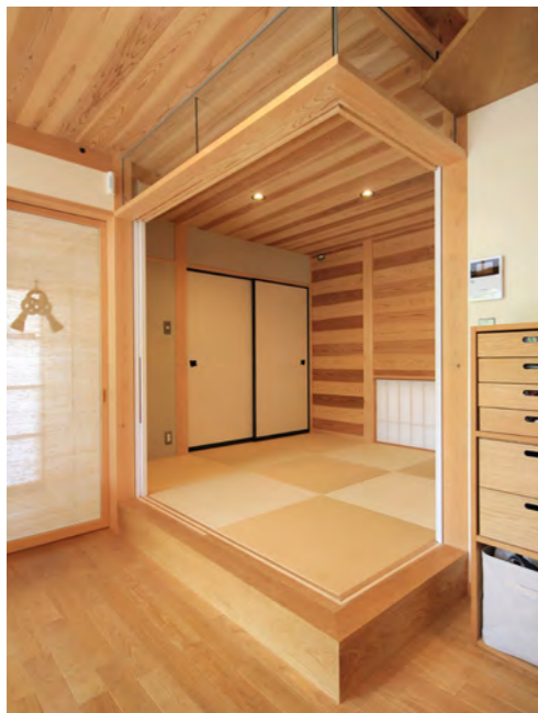
畳コーナーをダイニング側から見る。和室との段差を20cmとし、引き出しはつくらず、上り下りに無理のない高さを設けた。畳コーナーを小上がりにする事で、ダイニングチェアに座った人との視線高さが合い、会話に違和感をつくらないようにしている。
