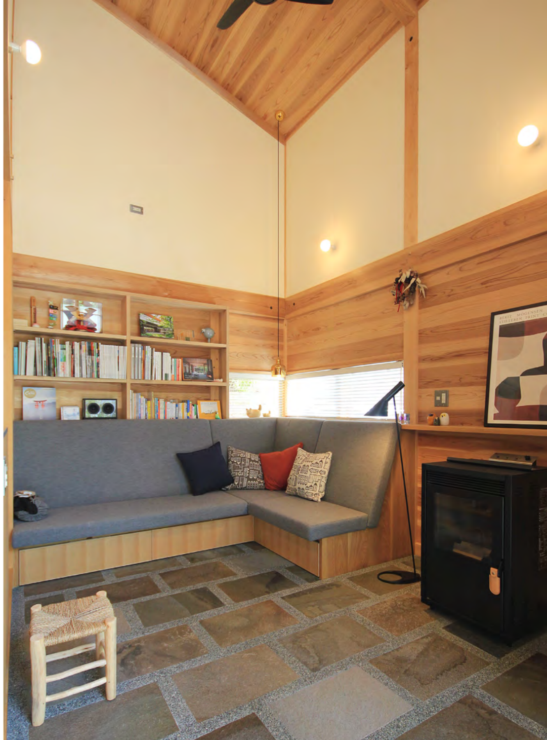
コーナーソファを造り付けた石土間の空間。石は諏訪鉄平石の方形に大磯砂利の洗い出しの目地で仕上げた。ソファは石土間に合わせてグレーをチョイスし、木と漆喰の空間に、シックで落ち着いた空間となった。
