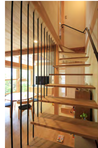
上) アイアン階段……階段内部から見ると段板が浮いている様子にも見え、木とアイアンの特性を活かした階段が出来た。アイアンバーは落下防止の柵にもなり、小さな子供も安心して上り下り出来る。
