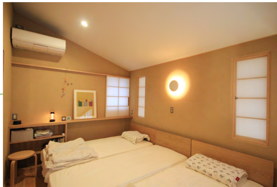
寝室……寝室は、土壁と障子を使った仕上げを提案した。土壁は表面に凹凸があり、音を吸収して落ち着いた空間をつくる事が出来る。天井は塗装屋さんが仕上げたマットなEP塗り。
