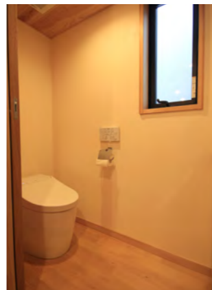
2階トイレ……2階のトイレは青森ヒバの床板と漆喰の壁で仕上げた。2階にトイレをつくるかどうかの基準は、2階に寝室があるか？を基準に検討している。
