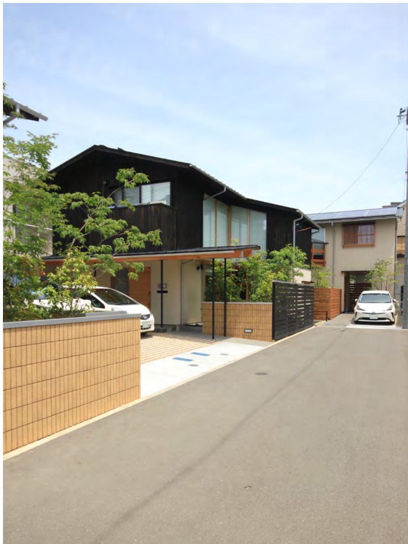
進入路から見た外観。1階の塗り壁と2階の黒壁が特徴で、植栽の緑やタイルの腰壁などが華やかさを添えている。黒壁は杉赤身板に柿渋を塗り、その上から柿渋コートG(黒と古代色のブレンド)を塗布している。
