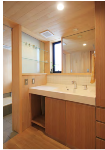
洗面脱衣室……カウンターをオーダーで注文し、扉や鏡、収納などをオリジナルで製作。住まい手の希望を反映でき、高さや使い勝手を考えて製作している。
