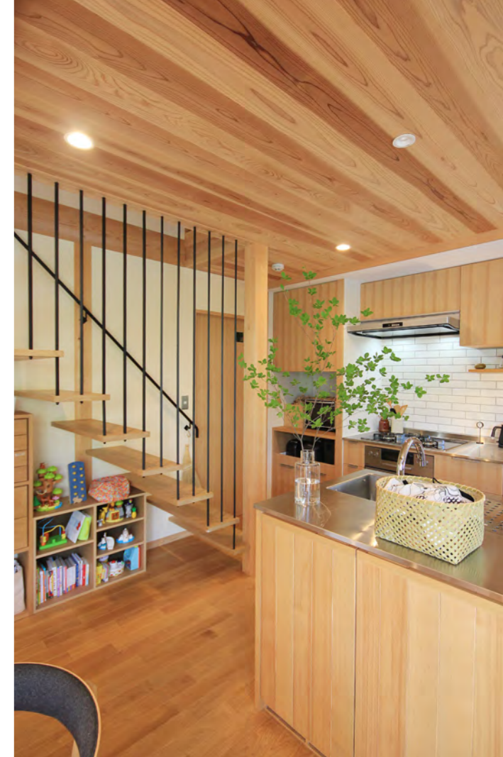
上) アイアン階段……階段内部から見ると段板が浮いている様子にも見え、木とアイアンの特性を活かした階段が出来た。アイアンバーは落下防止の柵にもなり、小さな子供も安心して上り下り出来る。
