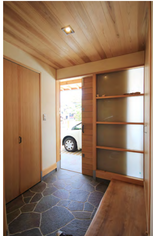
玄関……諏訪鉄平石の乱張り仕上げの玄関土間。自然味のある形が特徴で、石屋の腕が試される。明かり取りのガラスや一枚板の式台など、コンパクトながら工夫の詰まった玄関となった。
