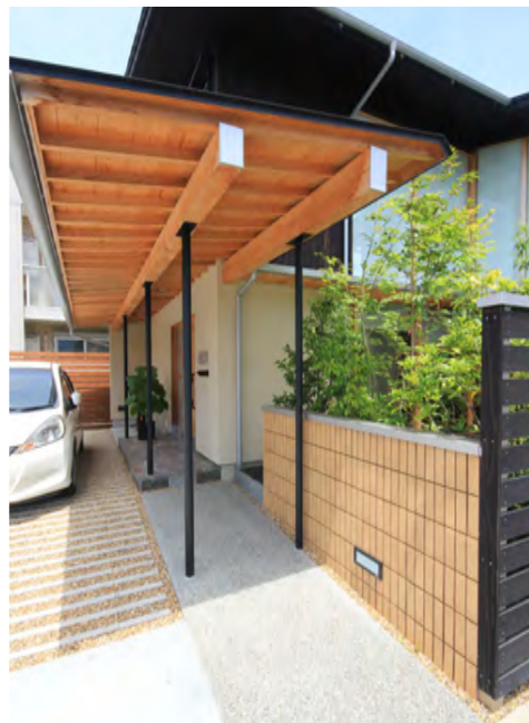
玄関ポーチの屋根をアプローチのスロープまで伸ばした。車からの乗り降りや、来客時などにとっても役立っている。柱はステンレスの焼き付け塗装品。存在感を少なくし、屋根を軽やかに見せてくれる。
