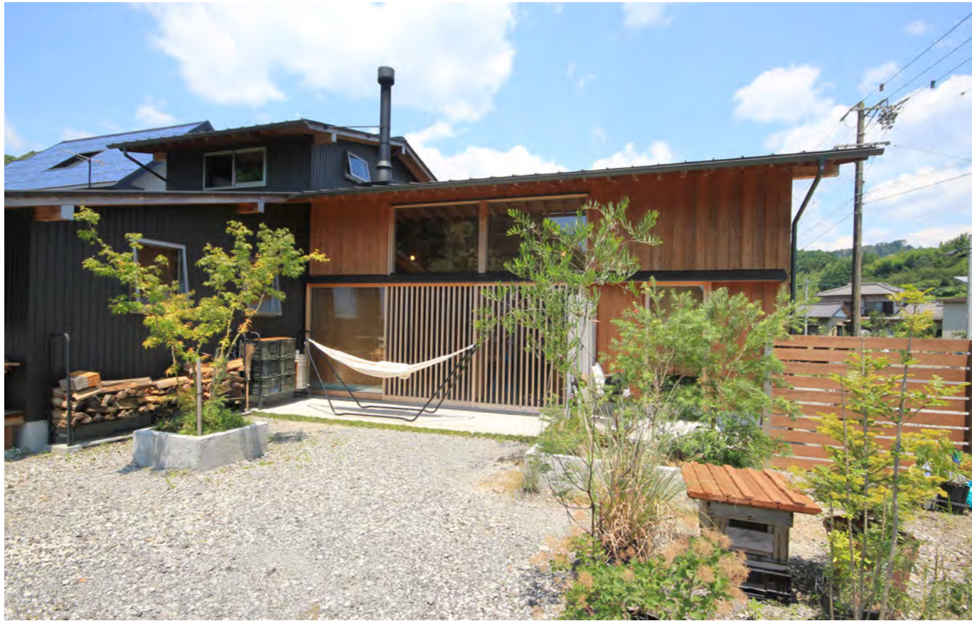
南からの外観。お店とリビングなどのパブリックスペースを木の外壁でつくり、寝室と子供室、水廻りをガルバリウム鋼板で仕上げている。平屋に一部2階のある伸びやかな外観となった。
