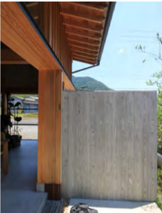
杉板型枠のコンクリート腰壁。近くで見ると杉の木目がくっきりと浮かび上がり、優しい風合いの壁になった。
