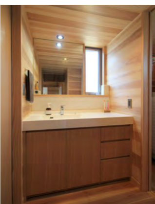
カウンターは、ボウルと一体型にしたオーダーメイドで、扉や引き出しを取り付けたオリジナルの洗面化粧台。
