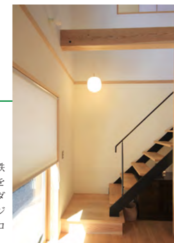
階段 コロラボ定番のアイアン階段。鉄板や丸棒を加工して、手づくりで階段を製作している。踊り場に吊るしたペンダントライトは、奥さんのこだわりのラジオハウスペンダント。真鍮とガラスのコンビがとても綺麗な照明器具。
