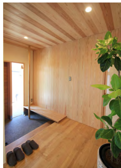
玄関ホール 杉板の壁を背面にして、ベンチと手摺を取り付けた。木の優しさが空間を包み込み、心地よい玄関ホールになった。
