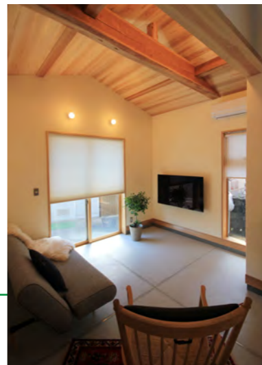
土間リビング 畳の部屋を土間空間につくり変えた。あえて見えるようにした屋根裏にあった太鼓梁がこの空間のポイントになっている。
