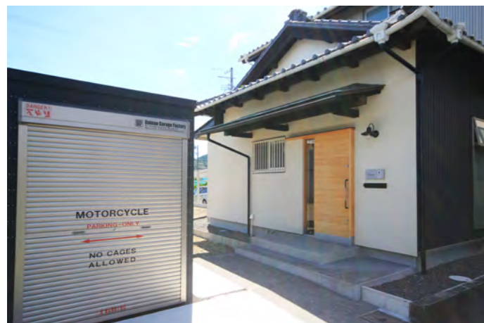
玄関ポーチ 外観は大きく変化していないが、玄関建具を新しく作り変え、一部の外壁を塗り壁にした。元々駐車場だった場所にご主人のバイク置き場を設置し、家族各々の暮らしが楽しくなった。
