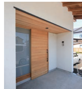
玄関ポーチ 板戸とFIXガラスを組み合わせたコロボ定番の玄関建具。取手のアイアンバーも手づくりで、職人のこだわりが感じられる玄関となった。外壁はマサ土掻き落とし仕上げとし、陰影で変化する表情が空間を高めている。
