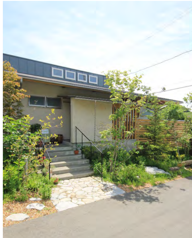
エントランスの階段はゆったりとした高さとした。階段の上り下りの際も植物に目が行き、四季を通じて楽しい発見がある。階段手摺や表札のある大谷石の壁も素材感が出ている。
