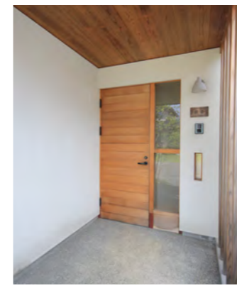
玄関ポーチのポストは玄関収納の一部につながる仕組みで、室内から郵便物を取り出せる。
