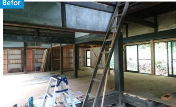
改築前の室内写真。室内も数年前に改築工事を計画したが途中で中止となり、そのままの状態となっていた。土壁が落ち、床や建具がない状態だった。
