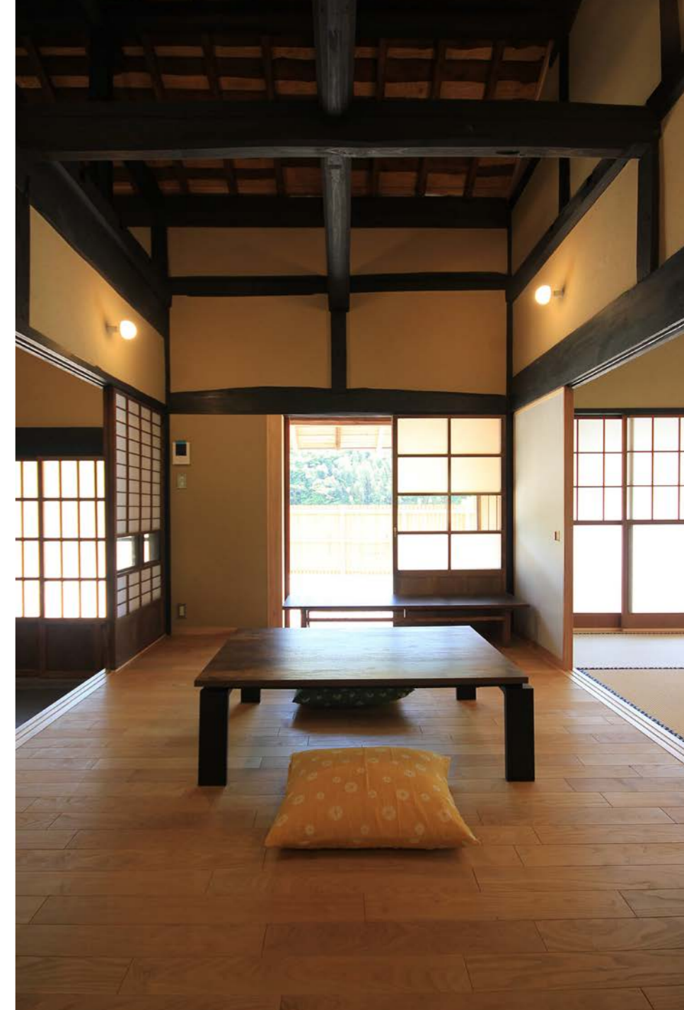
広間 元々座敷として使われていた部屋を板の間とし、フレキシブルに使える部屋とした。玄閣土間と同様に、天井を外し、小屋組を現した空間とした。
