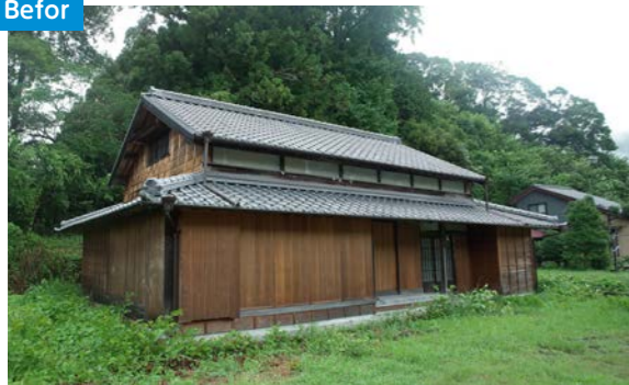
瓦と外壁がやり直してあり、外観的には見た目に傷んでいる様子は少なかった。初めて見たときは、こじんまりと可愛らしい古民家だと感じた。
