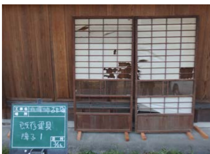
古民家の建具が倉庫に眠っていたので一枚一枚写真を撮って記録作り。ガラスや棧がかけたり、ベアの建具が無かったり色々あるが、設計の前に整理しておく事が重要。
