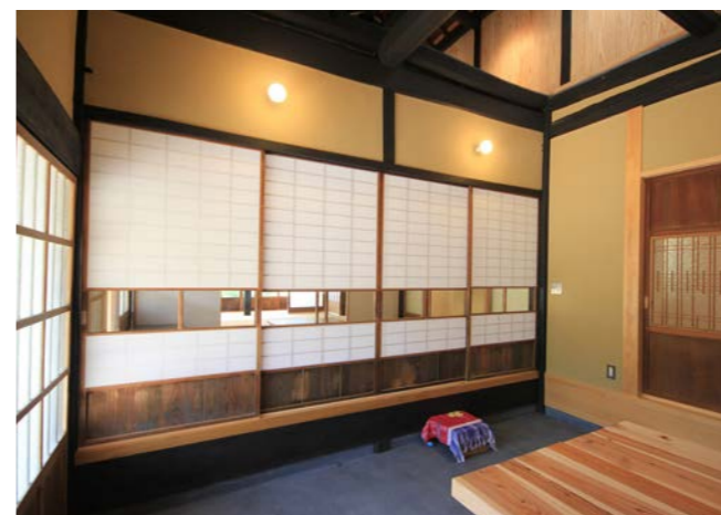
障子、板戸、ガラス戸など、タイプの違う建具が色々あり、使う場所を考えながら配置した。鍵や金物は昔風のものを探して取り付けた。
