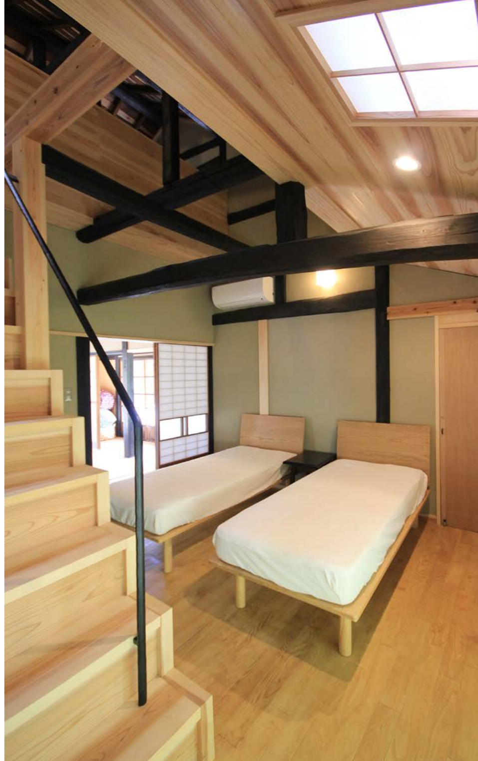
寝室 2台のベッドが置かれた寝室。元々縁側と納戸に分かれていた部屋だが、天井の梁を活かして寝室とした。寝室には小屋裏に登る階段をつくり、プラスαのスペースをつかった。
