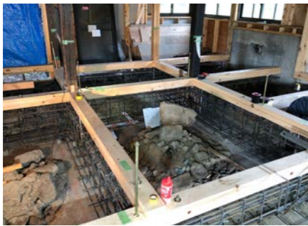
先行して土台をつくり、その下に鉄筋を組んでいく。土台や柱は所々、鋼製束で浮かしていきのが施工のポイント。鉄筋が組めたら型枠をつくる。
