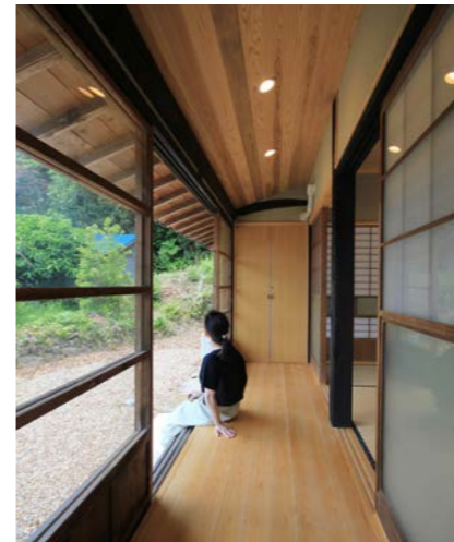
縁側 和室の周りを囲んでいる縁側。床、壁、天井を新しくし、建具はそのままのものを再利用した。古ガラスが雰囲気を出している。
