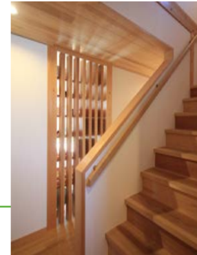
廊下・階段 書庫の通風と、廊下の明るさを確保するため格子を設けた。風や光だけでなく、人の動きも感じられ、家族の気配が広がる家となった。
