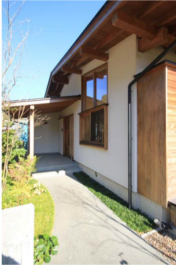
アプローチ 玄関前には、植栽を組み入れた土間のアプローチをつくった。ちょっとした余裕のスペースがあることで毎日の暮らしが楽しくなる。
