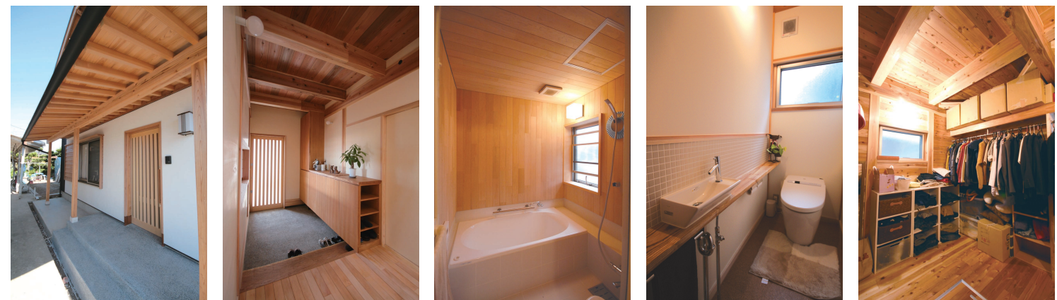
玄関の軒裏は、細かなピッチで垂木が掛けられている。漆喰壁と合わせて清潔感のある玄関になった。 玄関には、タモで造った大きな玄関収納を備えた。傘やスリッパの置き場所も考えられている。 青森ヒバとサーモタイルで造った浴室。ヒバの香りがとても爽やかで心地良い浴室と評判です。 タモのカウンターに小さな手洗器を付けた。前面にタイルを貼り、デザインと水跳ね防止を兼ねている。 4.5 帖の納戸。真四角の収納部屋は周りに衣類を置いて、部屋の中心で着替えなどが出来るとも便利。
