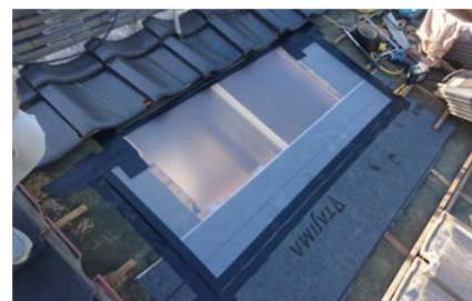
瓦の一部をガラス瓦に変えて天窓にした。今はあまり使われ無いガラス瓦だが、雨漏りの心配も少なく簡単に施工できるのがポイント。
