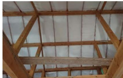
屋根面に高性能の断熱材を垂木間に入れた。屋根面での断熱は効果も高く、施工精度も良い。
