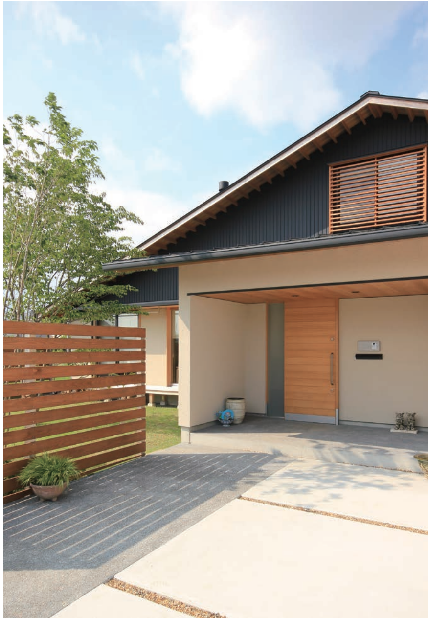
玄関アプローチから見た外観。ゆとりのある玄関ポーチが来客を迎え、ダイナミックな大屋根と2階の窓格子がこの家のファサードをつくっている。玄関先に置かれたシーザーや傘立ての壺など、Uさんらしいチョイスが来客を楽しませてくれている。
